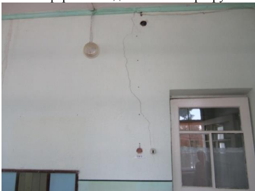
Трещины в несущих продольных стенах из-за осадки фундамента. Стены находятся в аварийном состоянии
