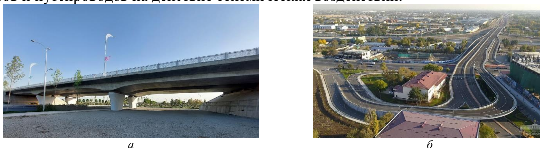
Рис. 1. Современные неразрезные (моноконтинные) железобетонные путепроводы, построенные в городах Самарканд (а) и Ташкент (б)
