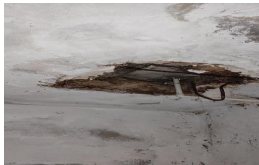
Рис. 5. Фрагмент конструкции перекрытия над подвалом. Выщелачивание и коррозия рабочей арматуры, пробитые технологические отверстия
