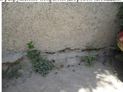
Цокольная часть здания из кирпичной кладки, из-за атмосферных осадков местами разрушена
