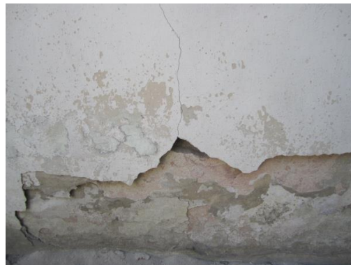
Трещины в несущих продольных стенах из-за осадки фундамента. Стены находятся в аварийном состоянии
