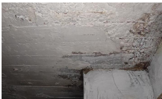
Рис. 5. Фрагмент конструкции перекрытия над подвалом. Выщелачивание и коррозия рабочей арматуры, пробитые технологические отверстия
